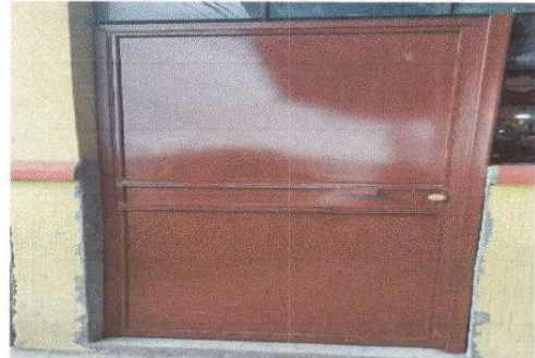
Foto 6: Sustrucción de puerta de metal.
