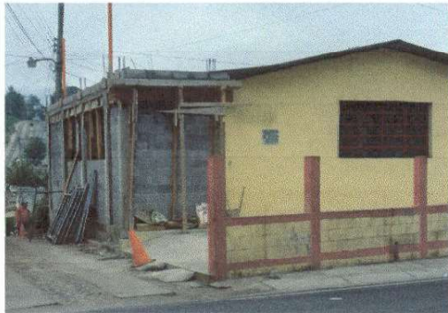
Foto1: Sustrucción de lamina por block en pared.
