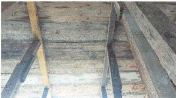
Foto 3: Sustrucción de techo de lamina por fundicion de losa.
