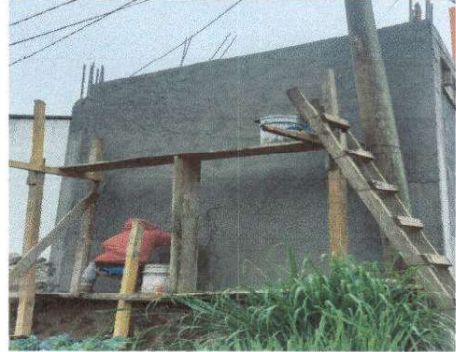
Foto 2: Sustrucción de lamina por block en pared.
