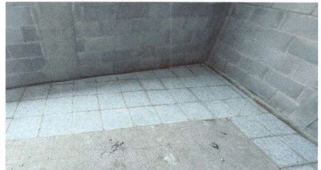
Foto 4: Sustrucción de piso de granito.
